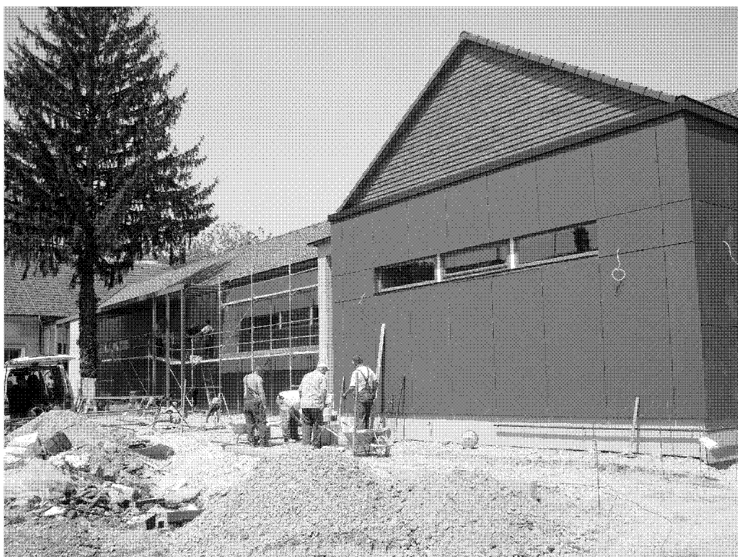
24. A volt Zeneiskola felújítása, átalakítása
