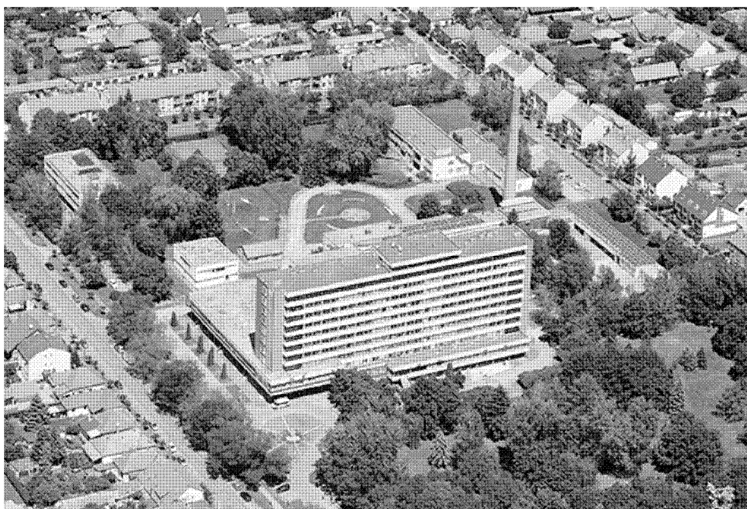
30. A kórház épületei rekonstrukciós és energetikai fejlesztésének helyszíne
