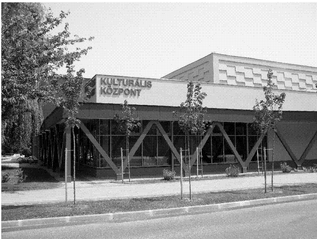
15. Az átalakított, felújított kulturális központ
